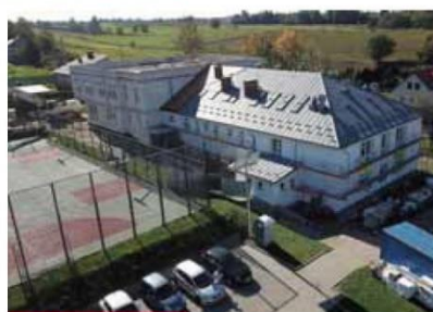
Przebudowa SP Snopków
