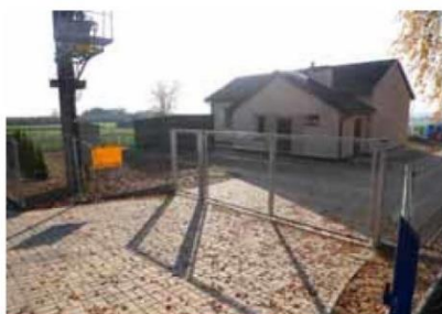
Stacja uzdatniania wody w Jastkowie
