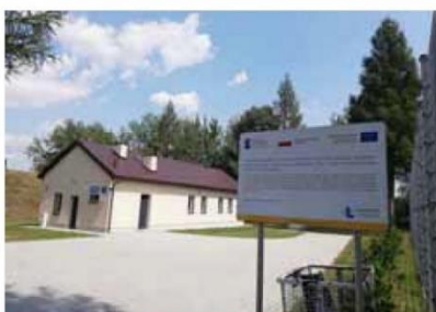
Stacja uzdatniania wody w Ożarowie
