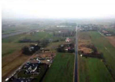
Przebudowa drogi w Marysinie
