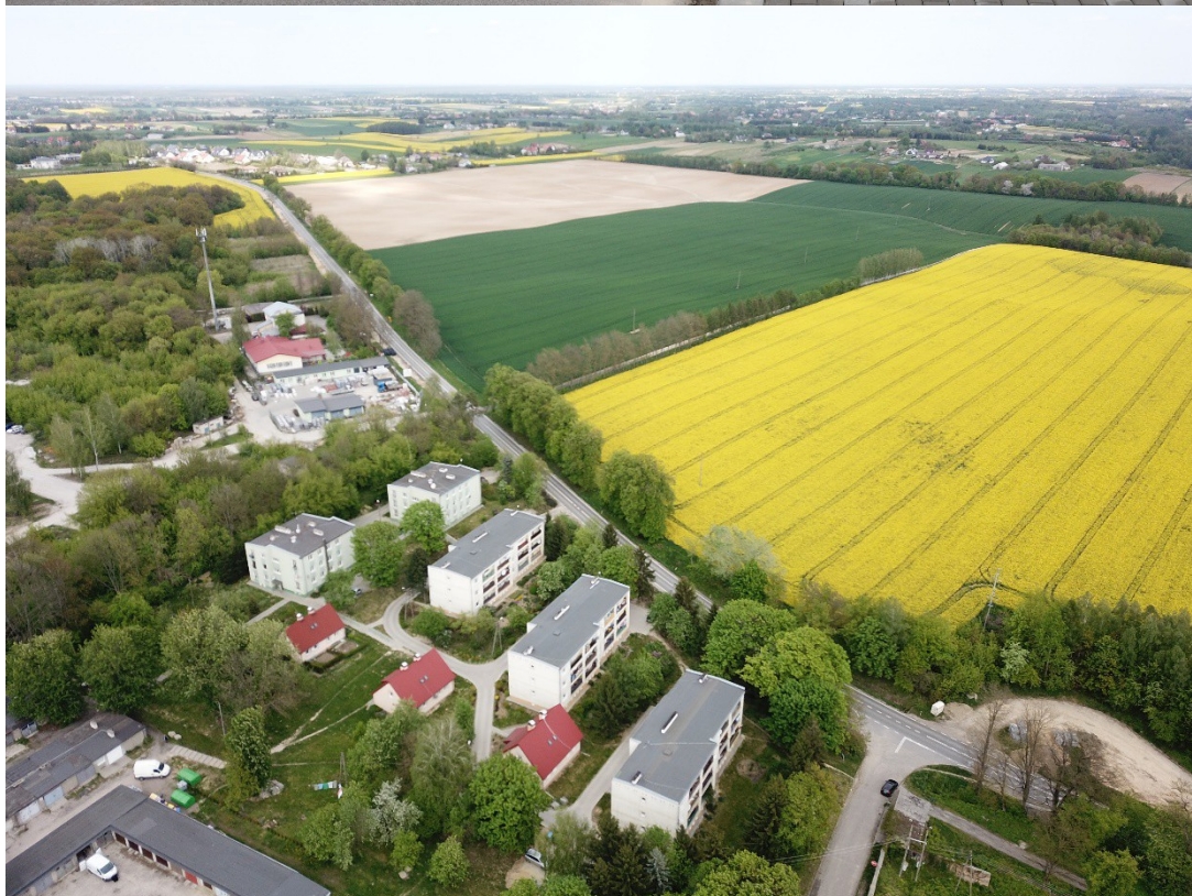
Foto. Przebudowa chodnika w pasie drogowym drogi powiatowej Nr 2418L w miejscowościach Natalin i Snopków.
