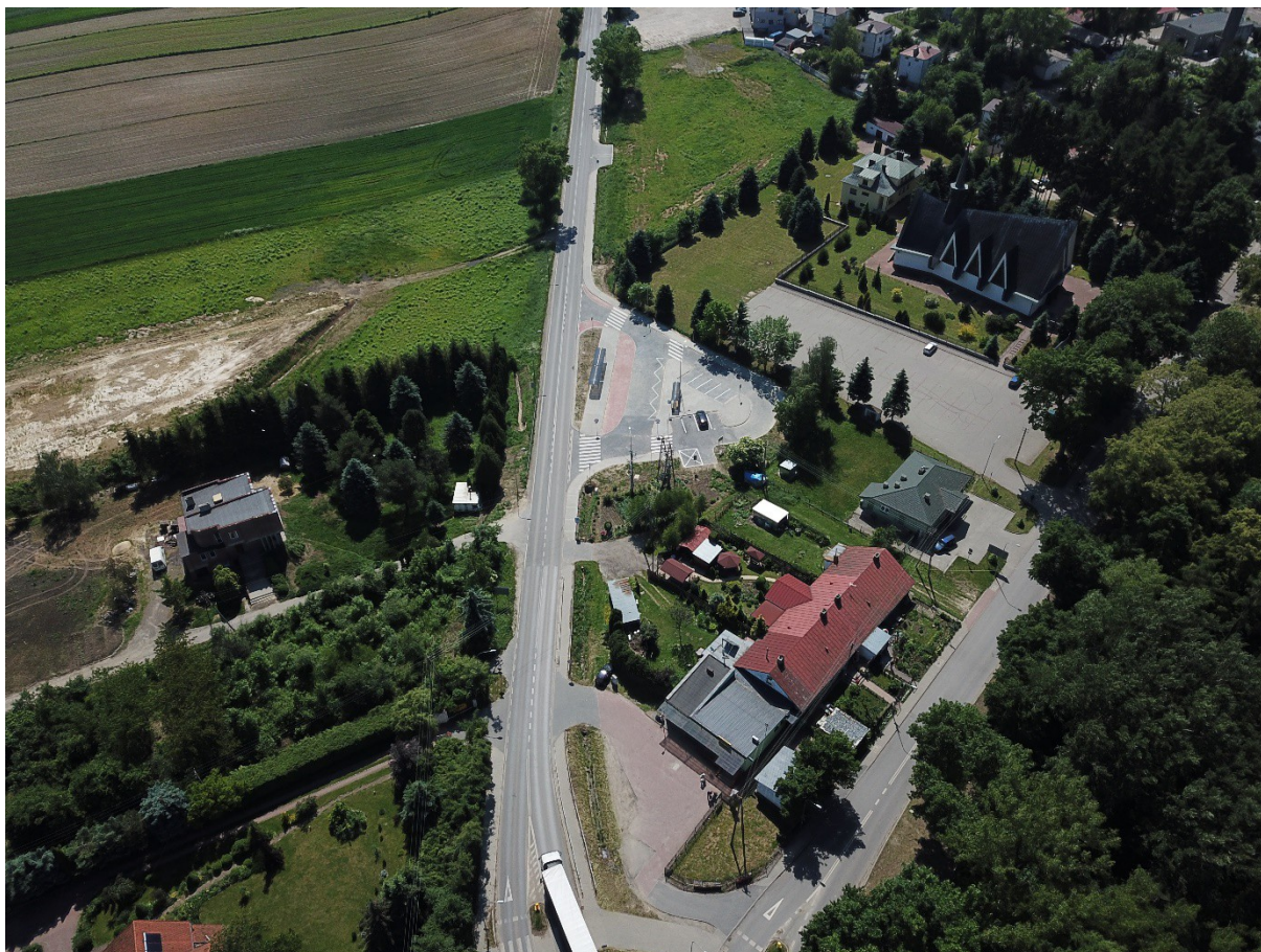
Foto. Węzeł przesiadkowy w Tomaszowicach Kolonii
