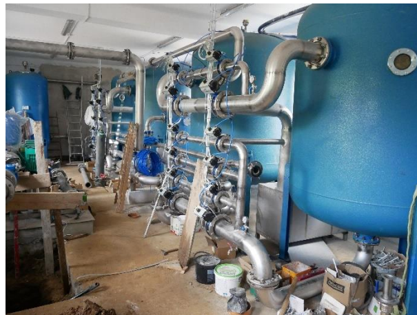
Stacja Uzdatniania Wody w Ożarowie
